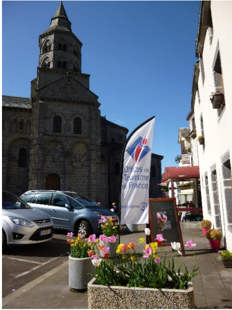
Façade extérieur côté Basilique
