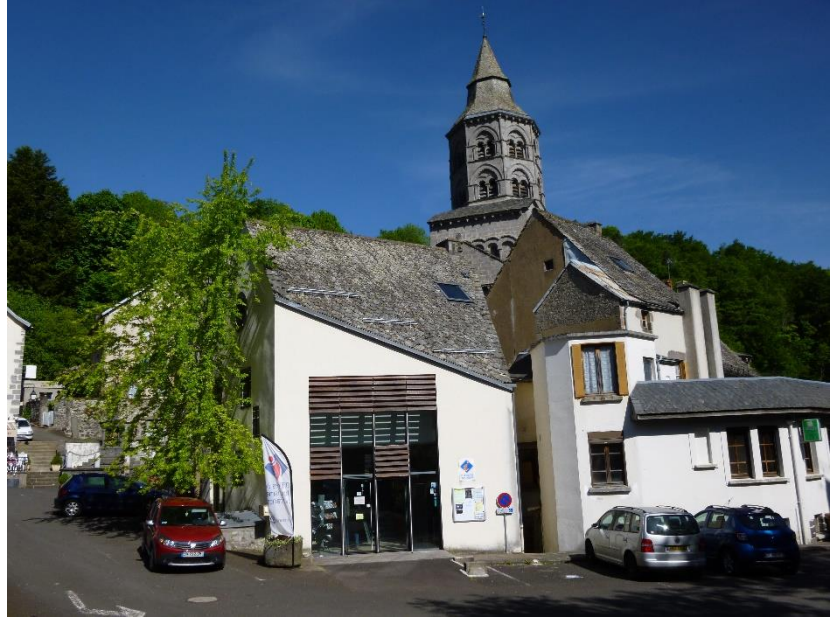
Façade extérieur côté rue
